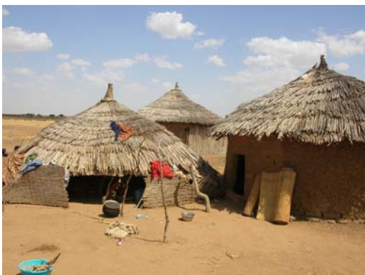
Photo 3 : Toiture de chaume habitation à Beiga (Sahel)
