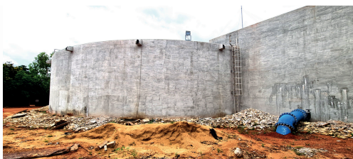
Bâche de 5000 m3 de Bolomakoté
