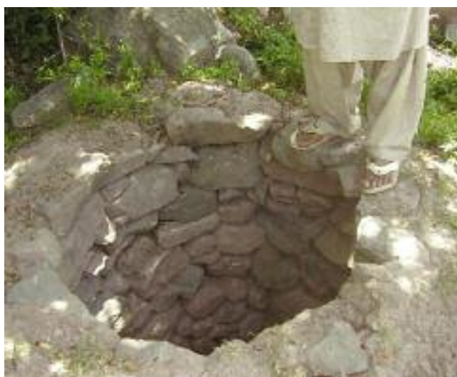
CI-DESSUS Pierres utilisés pour les revêtements d'une fosse de drainage. Photo : Syed Shah Nasir Khisro, IRSP, Mardan, NWFP, Pakistan.
