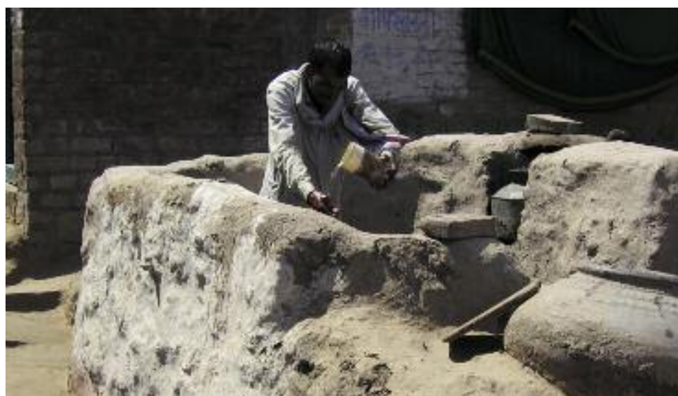
CI-DESSUS Plateforme de toilettes surélevée pour éviter les inondations saisonnières en Indonésie.
