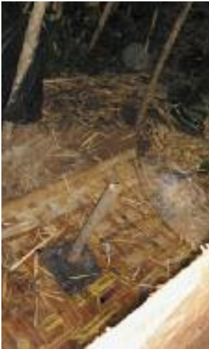
A GAUCHE Une latrine à fosse simple construite immédiatement après le Déclenchement de l'ATPC dans un village de l'Uletana Bakole près d'Arbaminch en Ethiopie. Utilisation de matériaux disponibles localement tels que le bambou, les nattes et le pastique. Souvent, les latrines sont améliorées progressivement.
