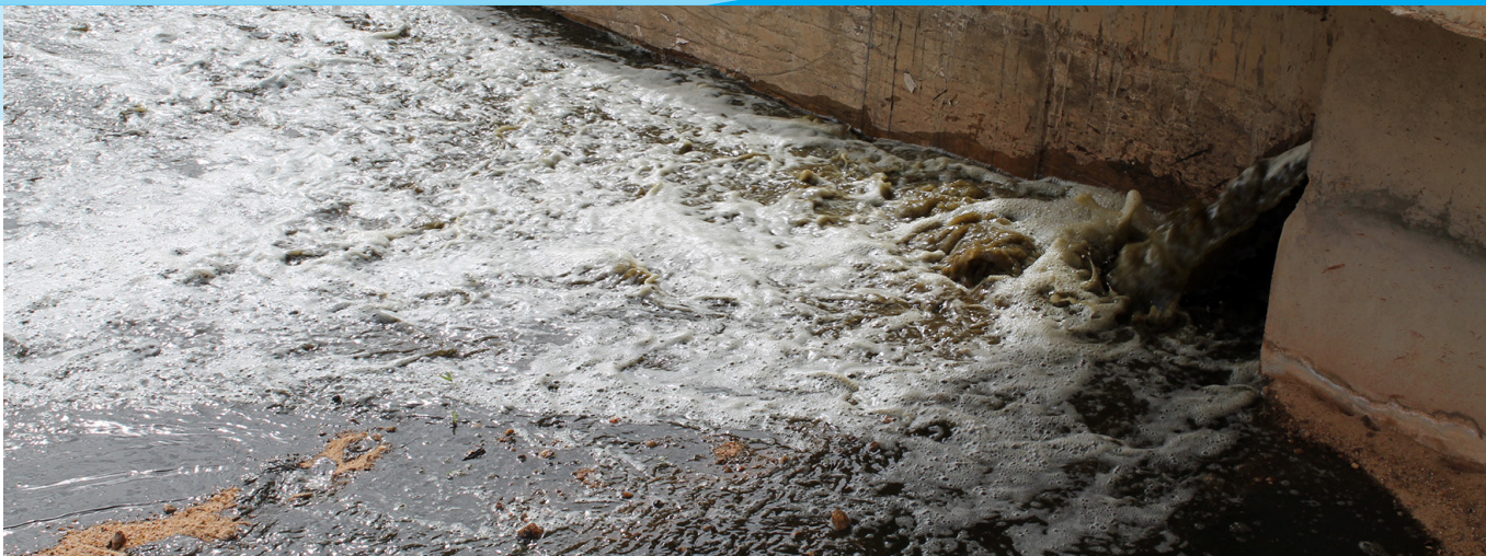
Une vue de la station de boue de vidange
