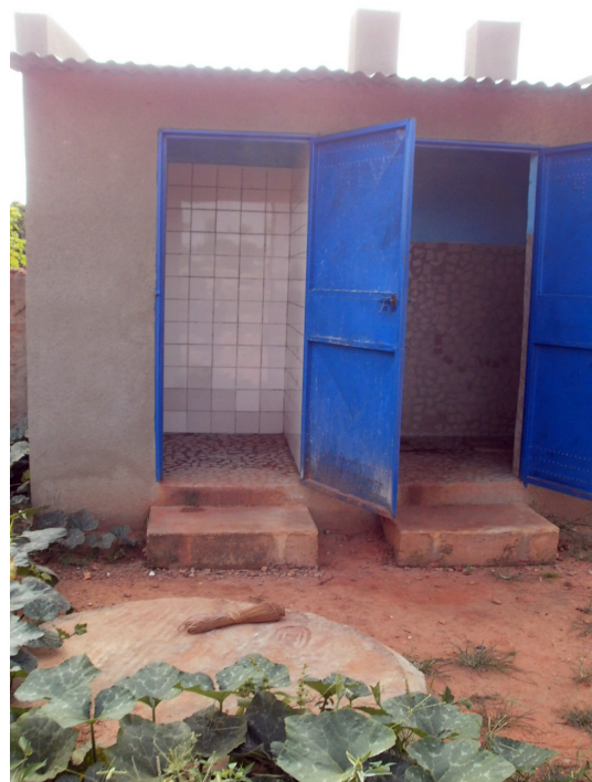
latrine et douche- puisard
