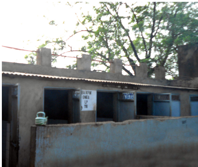
Une latrine publique de la gare routière de Boromo
