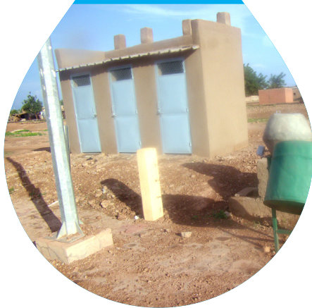
Bloc de latrines dans un centre de santé
