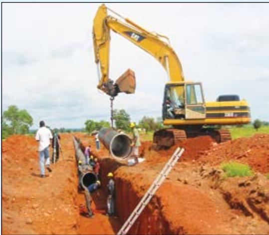
Travaux de pose de conduite
