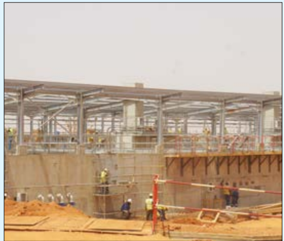
Deuxième station de traitement d'eau potable de ZIGA en construction
