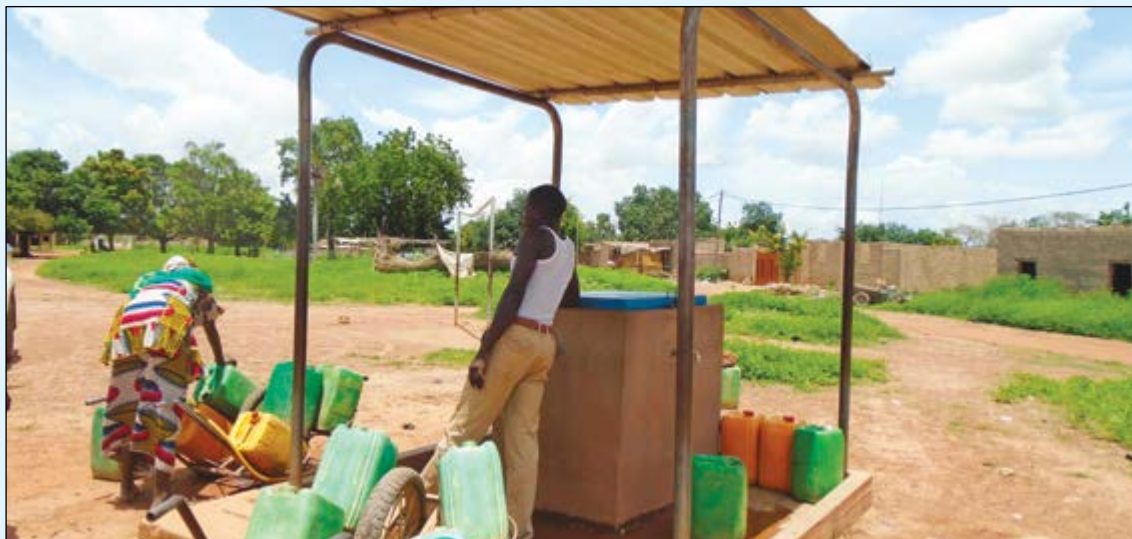
Approvisionnement en Eau Potable à partir d'une borne fontaine
