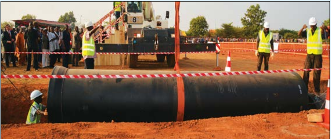
Acte de lancement des travaux de Ziga II
