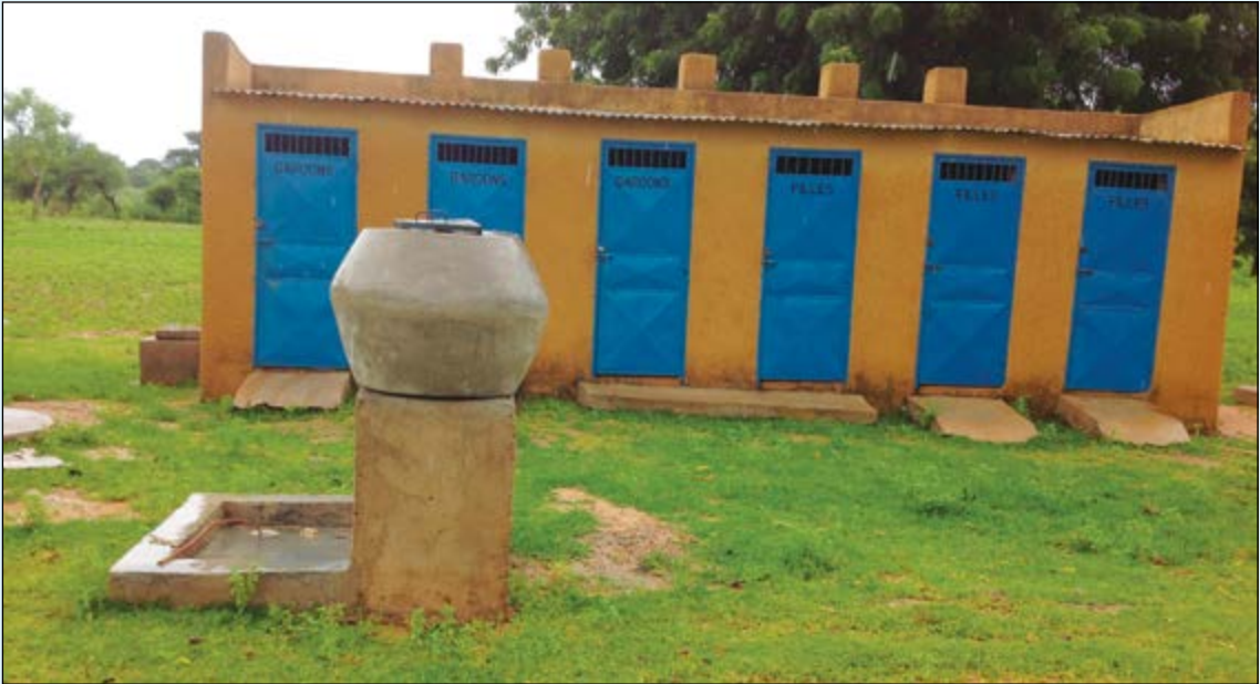
Bloc de latrines réalisé avec les fonds transférés à l'ONEA
