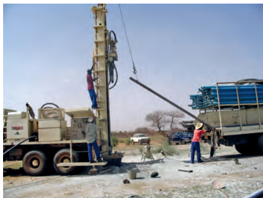
Tubage d'un forage
