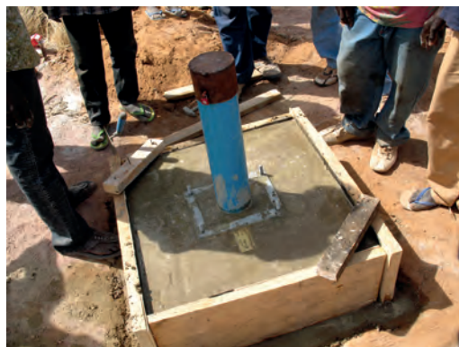
Réalisation d'une margelle
