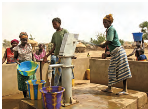
Forage équipé d'une pompe à motricité humaine.
