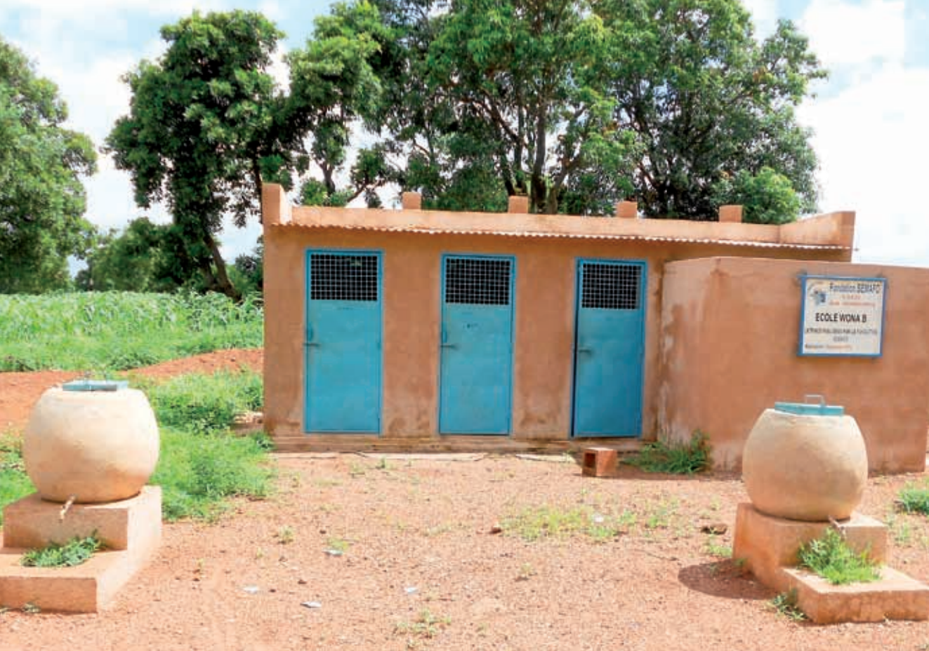
Latrine VIP avec dispositif de lave main réalisée par la fondation SEMAFO à l'école Wonan B
