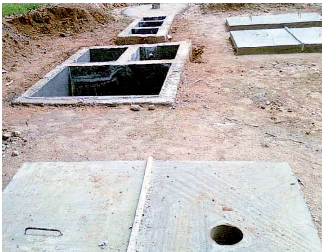
Réalisation d'une fosse septique en milieu urbain
