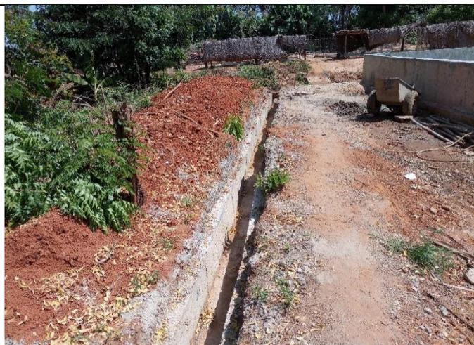
Photo 4 caniveaux en réalisation
