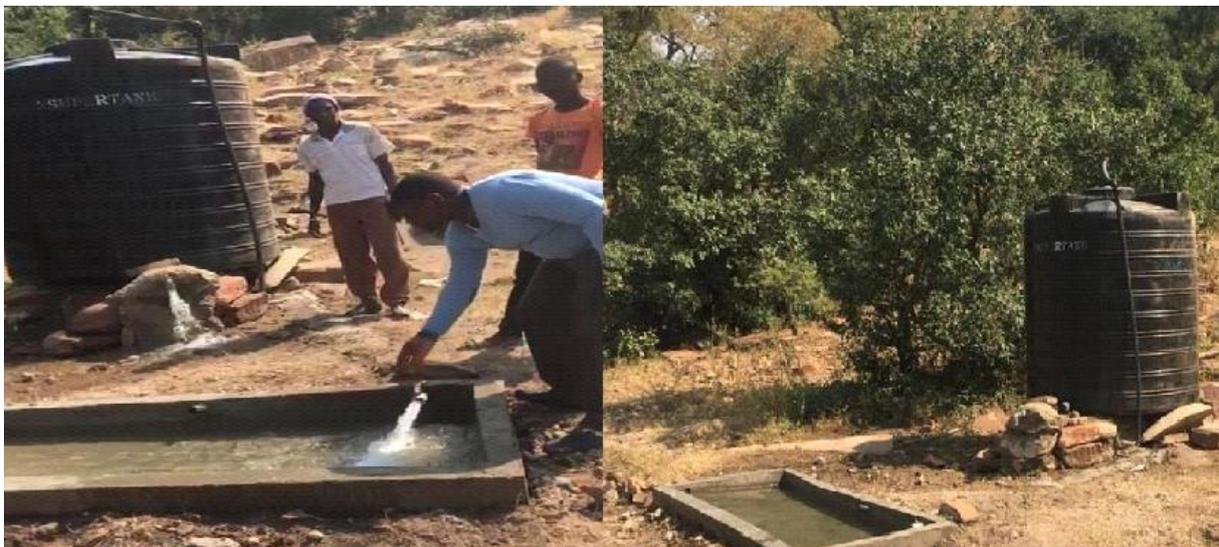
Photo 18 : Exemple de source aménagée avec réservoir de stockage
