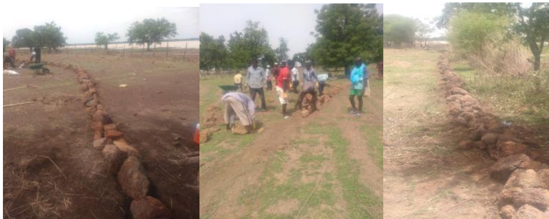
Photo 39 : Implantation des cordons pierreux par approche HIMO avec ProValaB
