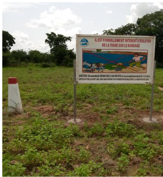
Photo 18 : Balise et panneau de sensibilisation dans la bande de servitude du barrage de Toécé
