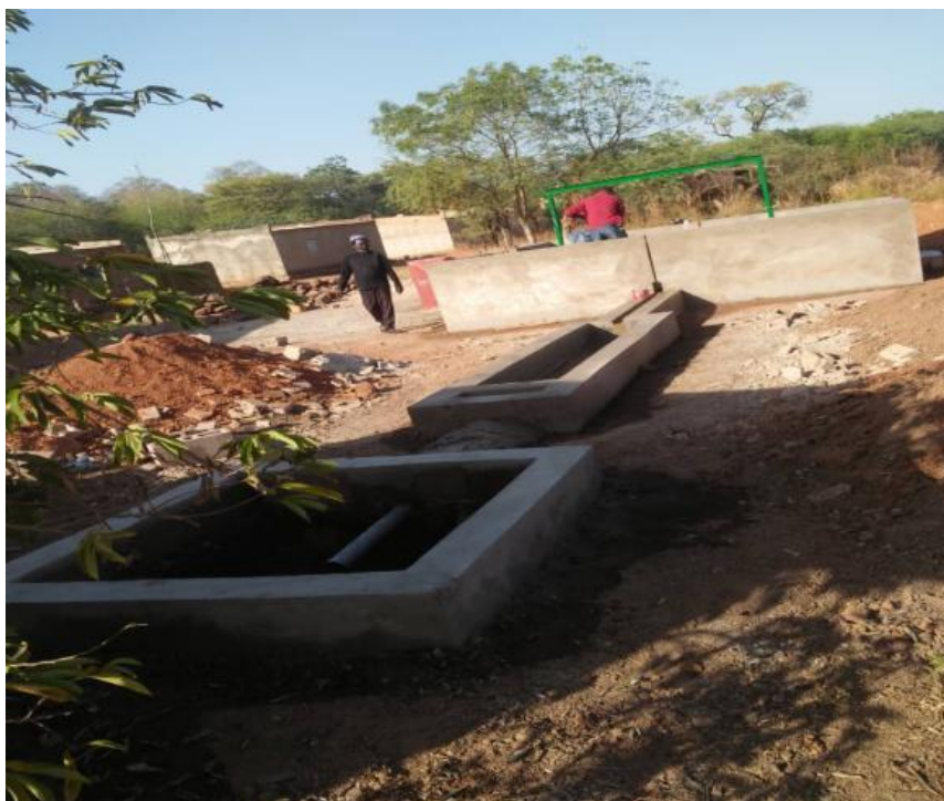
Photo 38 : Puits pastoral réalisé à Sossogona
