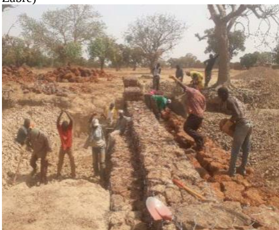
Photo 11 : Traitement de ravine sur les berges du barrage de Loumbila
