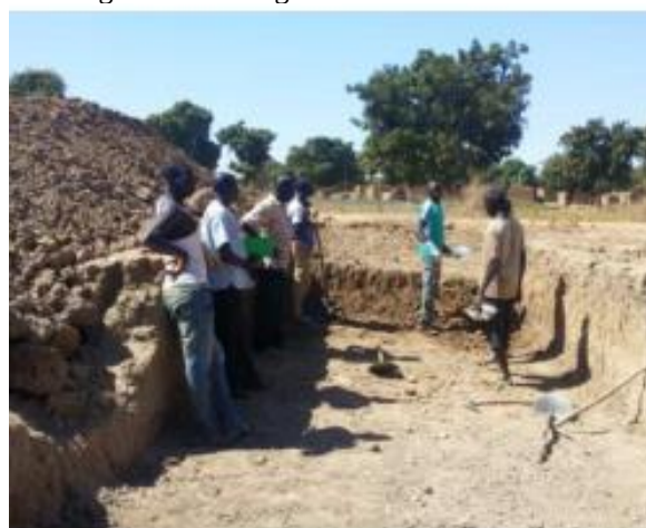
Photo 12 : Traitement de ravine au niveau du barrage de Loumbila
