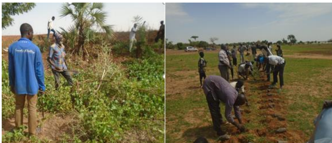
Photo 8 : Réalisation de la haie vive sur les berges du barrage de Titao et entretien de la digue du même barrage.
