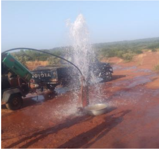
Photo 29 : Soufflage d'un piézomètre à Koumi
