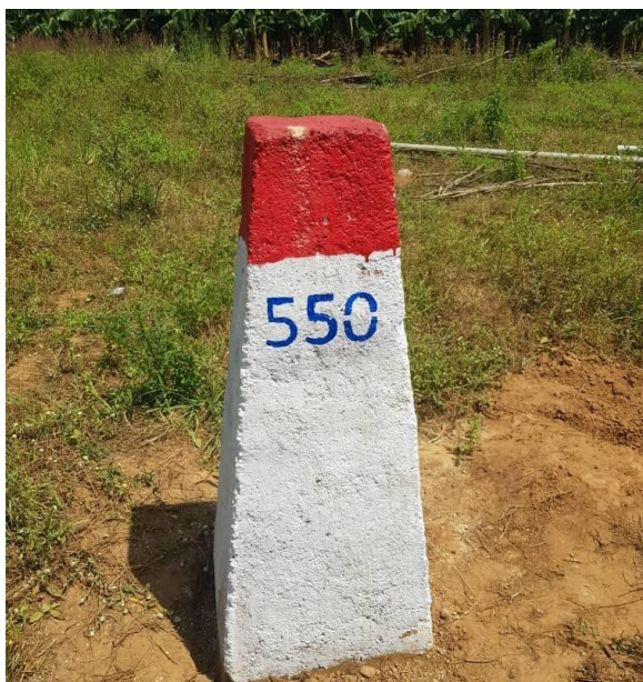
Photo 17 : Balise n°550 dans la bande de servitude du barrage de Toécé
