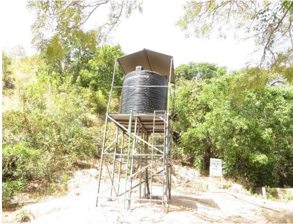
Photo 31 : Poly tank servant de réservoir tampon (Mê)
