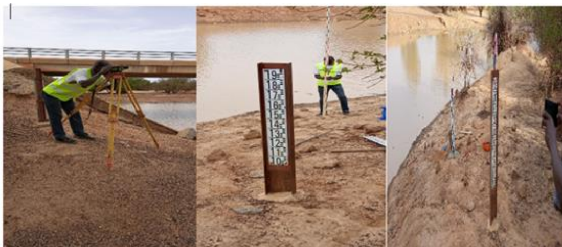
Photo 41 : Installation de l'échelle 0-1 à la station de Wayen
