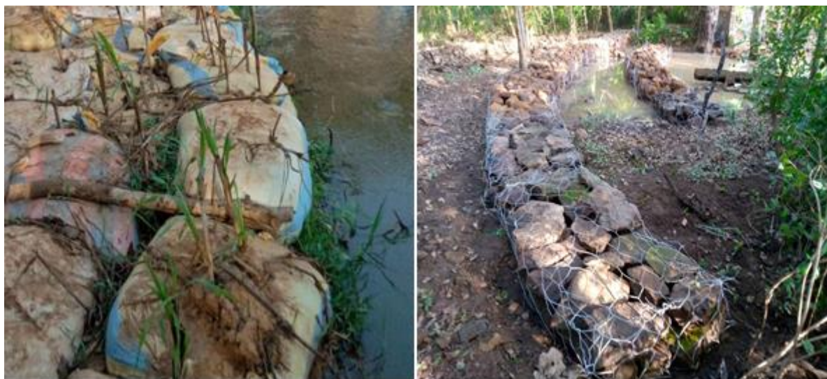
Photo 24 : Innovation locale de colmatage de brèche du Kou (gauche) et traitement de ravines dans la forêt classée du Kou (droite)
