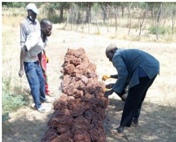
Photo 10 : Réalisation de cordons pierreux au niveau du barrage de Tamassogo
