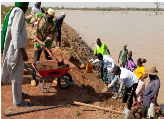
Photo 15 : Entretien du barrage de Lalgaye par le CUE (Renforcement du perré du talus amont)
