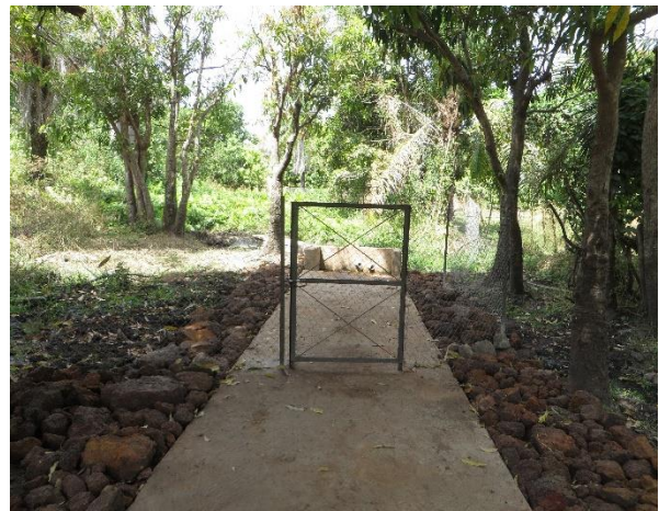
Photo 34 : Vue après travaux (Kassanga)
